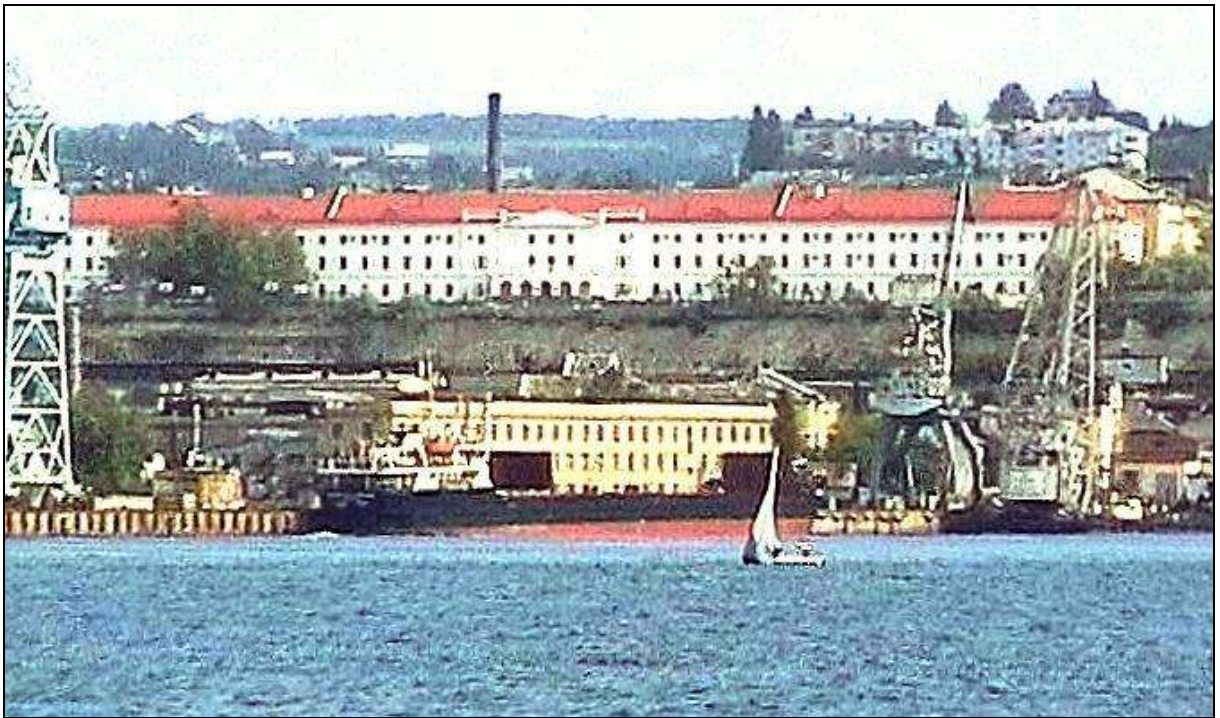
Bild 86 (Standbild aus Video) Das Lagergebäude in der „Bucht Hollandija“, Sevastopol
