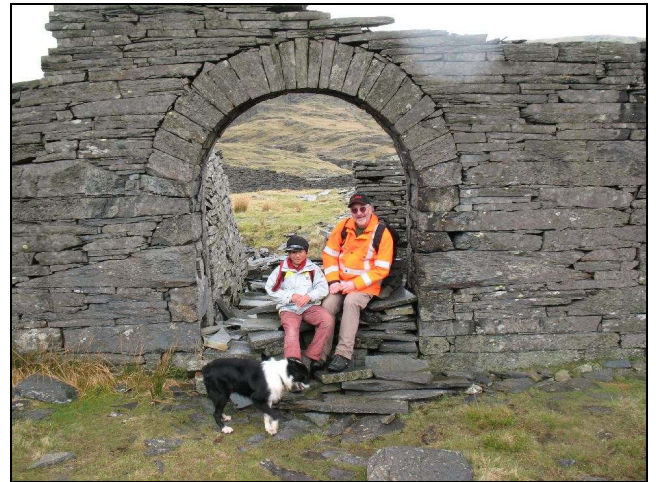
Trocken gemauertes Schiefergebäude
