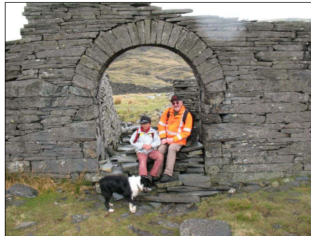
Trocken gemauertes Schiefergebäude
